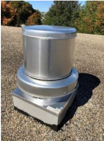
Roof Exhaust Fan
